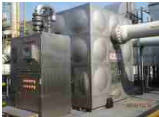
10、20、30、40线共用分子裂解装置现状图
