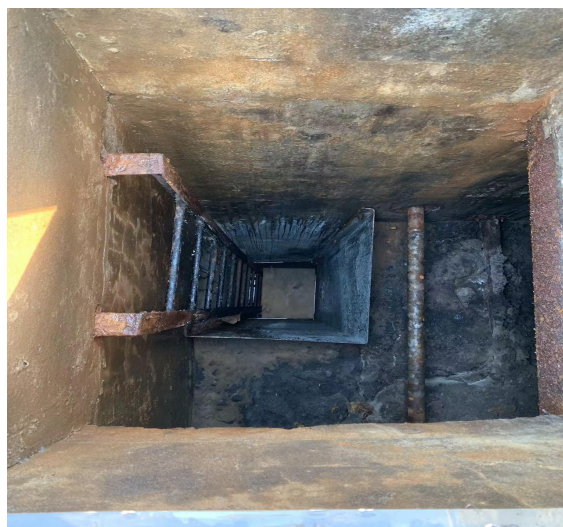
图 4.1-2 地下储罐区检查井照片
