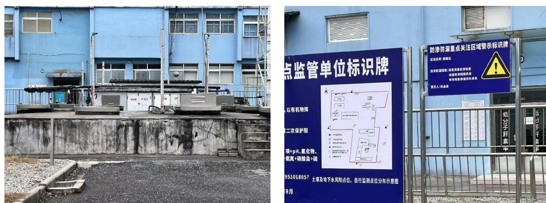
图 4.1-1 地下储罐区现场照片
