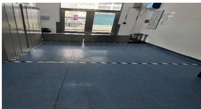
图 4.1-7 仓库地面防渗情况
