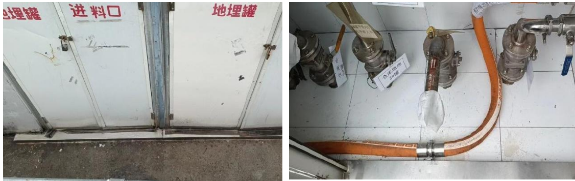
罐区进料口及地面防渗
