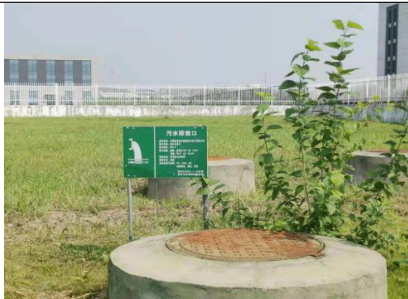
污水排放口标识牌
