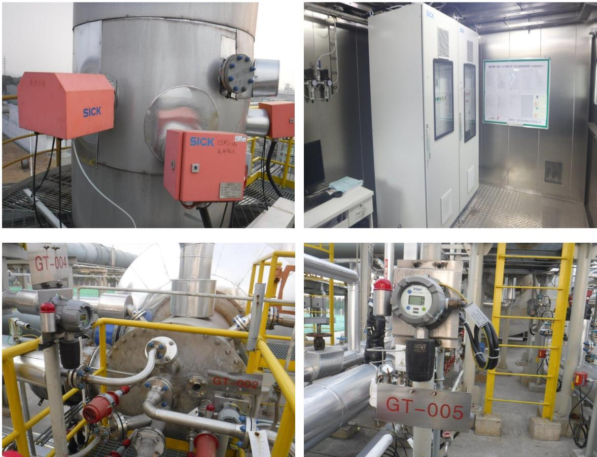
图 3-6 CEMS 烟气在线及可燃、有毒气体在线监测
