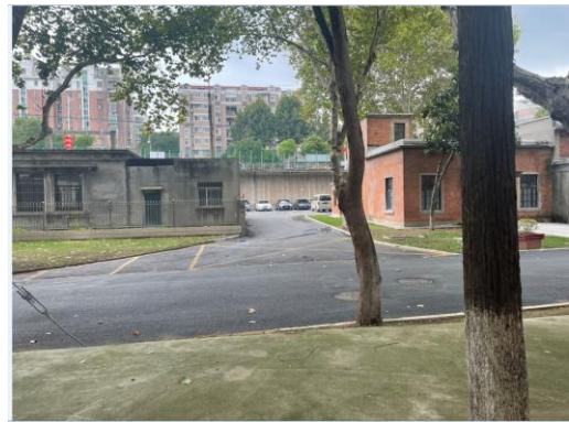
改建 CT 探伤室南侧
