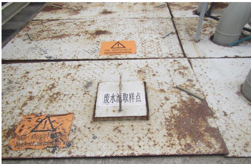
图 3-2 本项目依托复合材料（COMP）装置废水收集池
