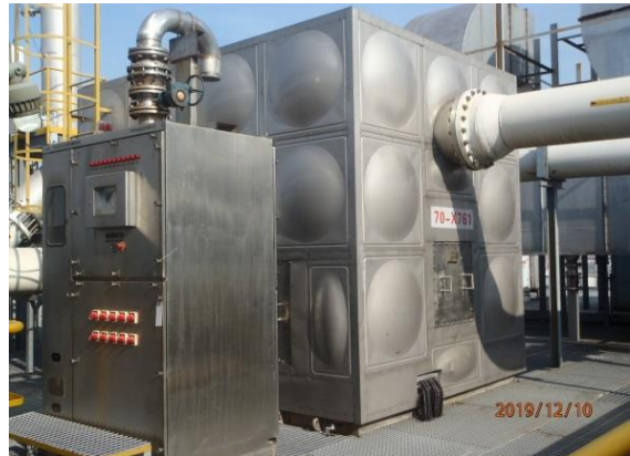
10、20、30、40 线共用分子裂解装置现状图
